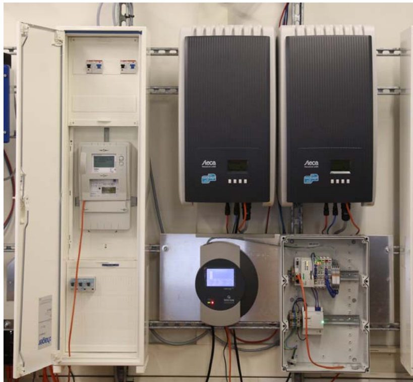
Abbildung 10: Testfeld 2 mit zwei StecaGrid 2300, einem SolarLog 1000 und einer SPS Steuerung für die Wirkleistungsregelung in 4 Schritten (0%, 30%, 60%, 100%) unter Verwendung des Kommunikationsprotokolls IEC 61870-5-104
